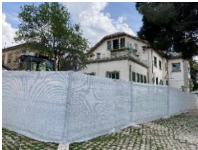
改修が始まった本館
